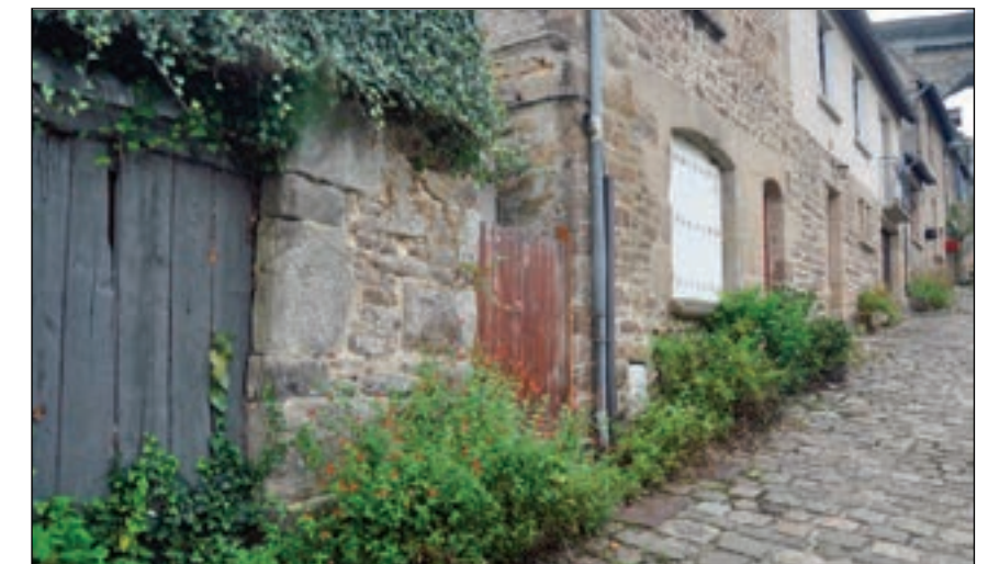
Fig. 167 : Pieds de mur à l'alignement végétalisés - Rue du l'Abbaye à Lanvallay
