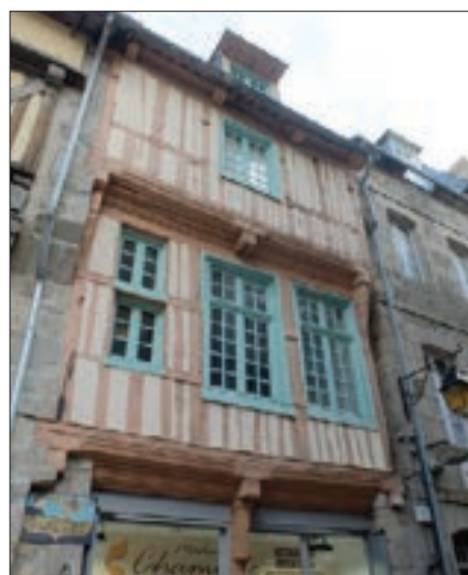
Fig. 231 : Maison, 3 rue de la Mittrie
