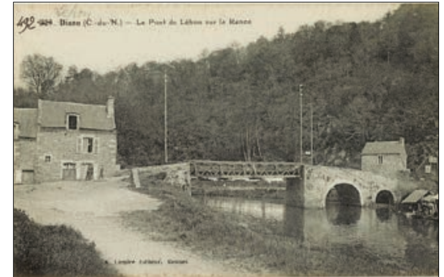
Fig. 126 : Le pont de Léhon sur la Rance
