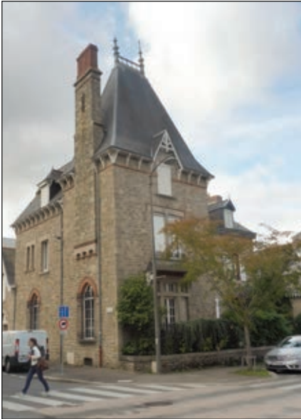
Fig. 316 : Quartier de l’Engoulevent à Dinan
