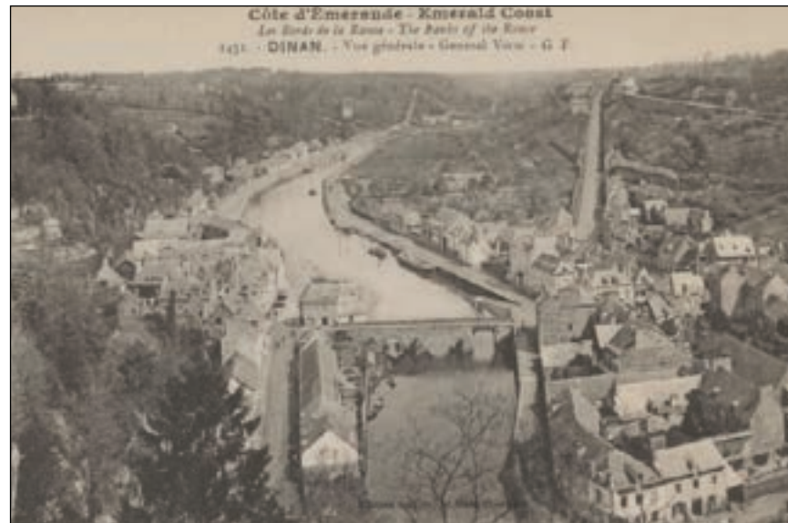
Fig. 110: Dinan, Vue générale prise du Saut de l'Âne (1910-1920)
