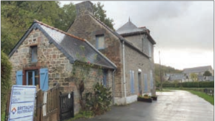
Fig. 282 : Maison d’éclusier, écluse n° 47
