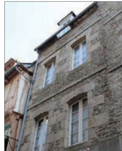
Fig. 232 : Maison, 5 rue de la Mittrie
