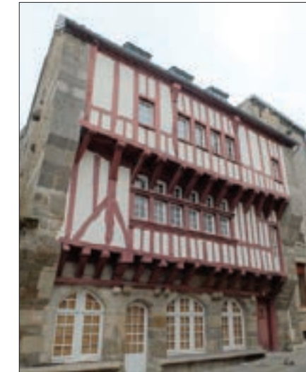
Fig. 206 : Maison, 6 rue Haute-Voie
