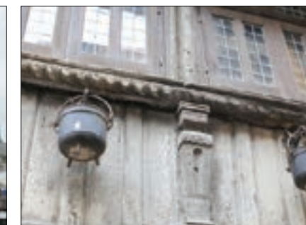
Fig. 216 : Maison, 8 rue de la Cordonnerie
