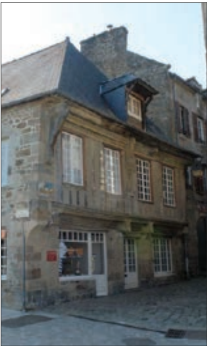
Fig. 248 : Maison, 82 rue du Petit-Fort
