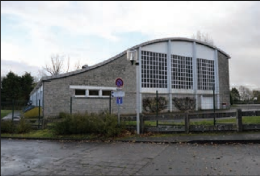
Fig. 299 : Gymnase lycée Fontaine des Eaux à Dinan
