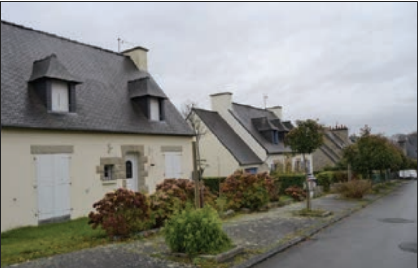
Fig. 358 : Pavillons dans le quartier des Buttes, Dinan
