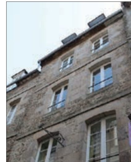
Fig. 237 : Maison, 7 rue de la Mittrie
