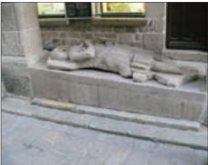
Fig. 249 : Maison du Gisant, 51 rue du Petit-Fort
