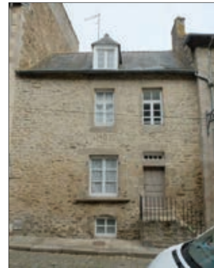
Fig. 212 : Maison, 3 rue Coignet
