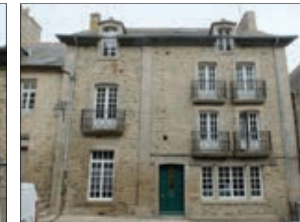
Fig. 213 : Maison, 5 rue Coignet
