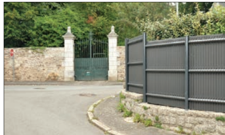
Fig. 176 : Portail monumental et clôture rue Ange Dubreuil à Dinan
