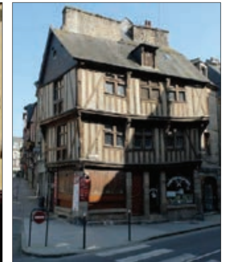
Fig. 210 : Maison, 20 rue de la Ferronnerie
