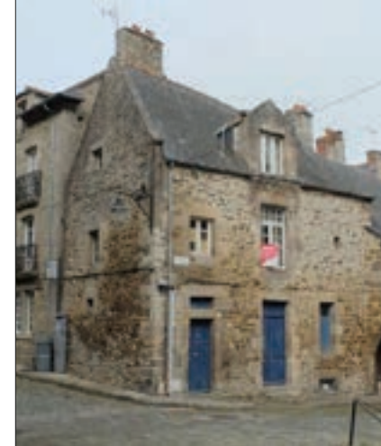
Fig. 214 : Maison, 7 rue Coignet
