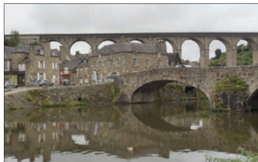
Fig. 156 : Viaduc de Dinan et Vieux Pont (Dinan-Lanvallay)
