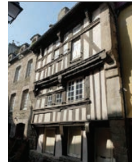
Fig. 205 : Maison, 20 rue de la Ferronnerie
