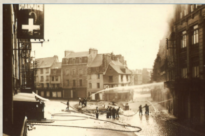
Incendies suite au bombardement du 2 août 1944. Immeuble place du Marchix : photographie. Coll. AM Dinan
