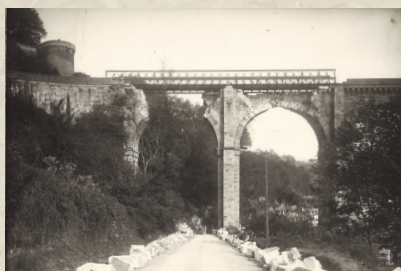
Pont Bailey posé sur le viaduc de Dinan dans la nuit du 6 au 7 août 1944 (Coll. B.M. de Dinan)
