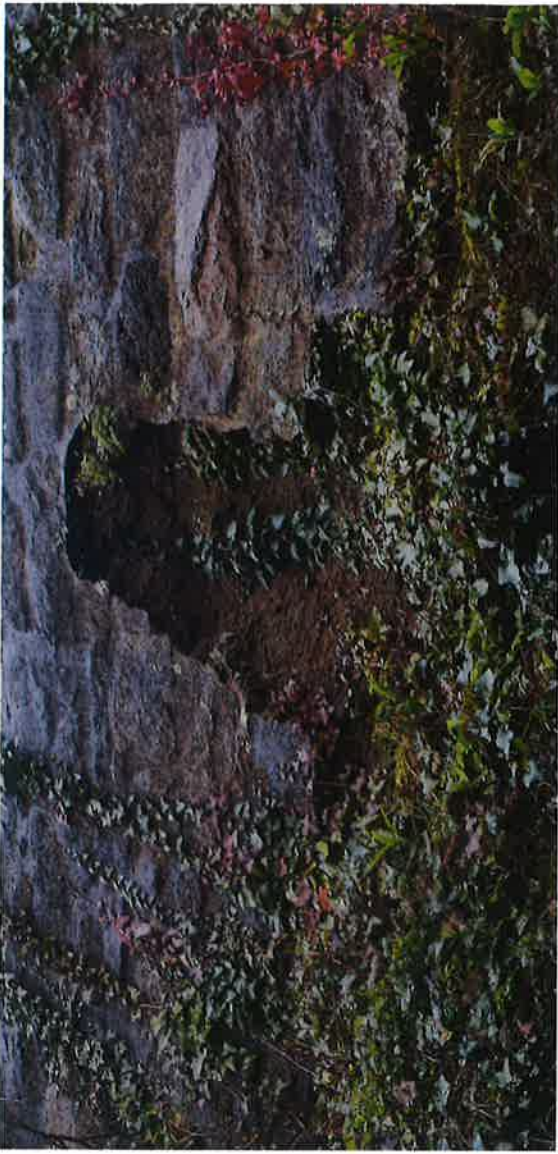
Désolidarisation du parement extérieur par un défaut d'origine, insuffisance de pierres positionnées en boutisse (manque de chevauchement des pierres pour assurer les liaisons internes), la déformation va évoluer lentement jusqu'à l'éboulement.
